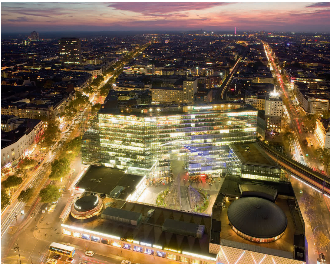
Das von Apleona Real Estate verwaltete Objekt „Kranzler Eck Berlin“
